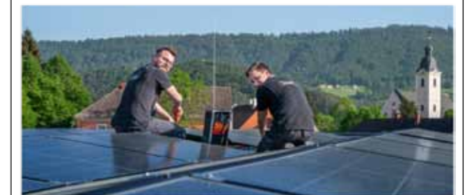
Neue Herausforderungen erfordern eine neue Arbeitswelt FREYDL
